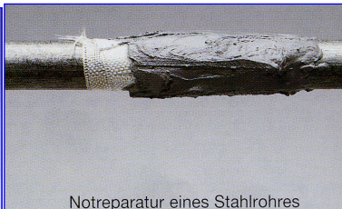
Notreparatur eines Stahlrohres
